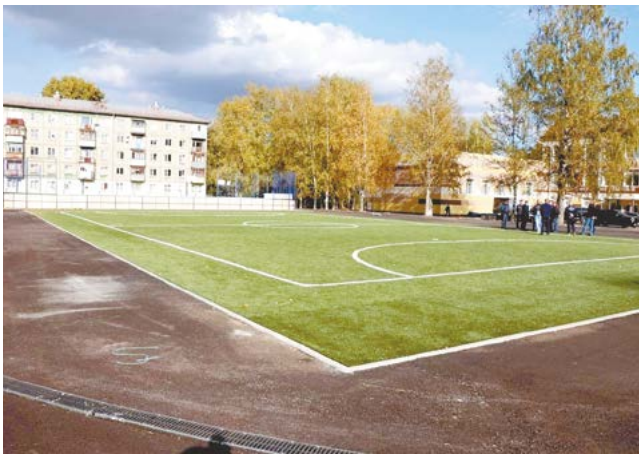
Главный элемент новых стадионов — футбольные поля
