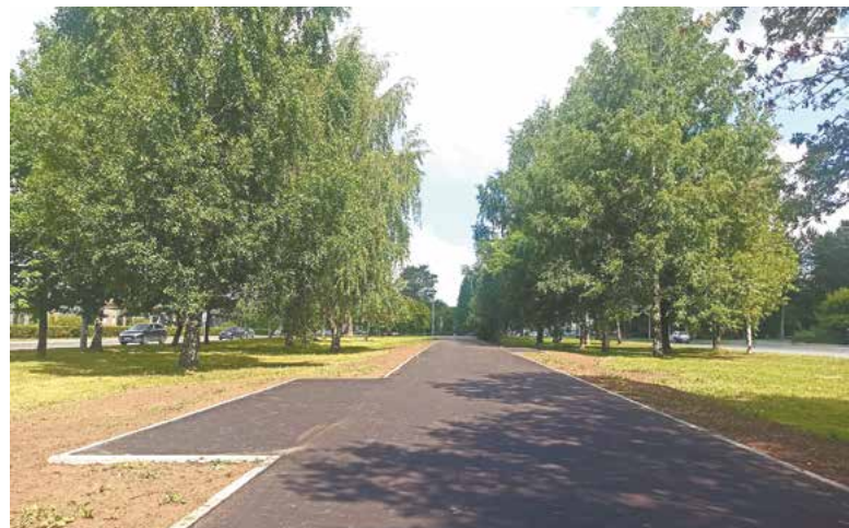
Разрушенную плитку на Сталеваров заменили на асфальт
