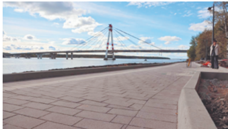
На Октябрьской набережной выполнили большую часть работ. Впереди — монтаж освещения и малых архитектурных форм
