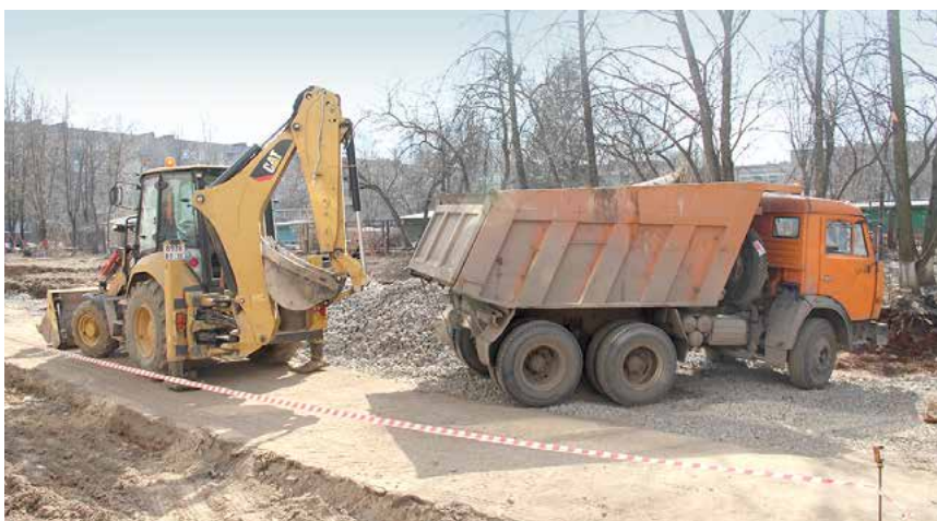
Завершив ремонт двора на Беляева, 12, строители перейдут на Беляева, 4а и 8
