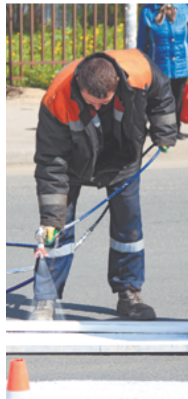
«Зебру» делают вручную по трафаретам
