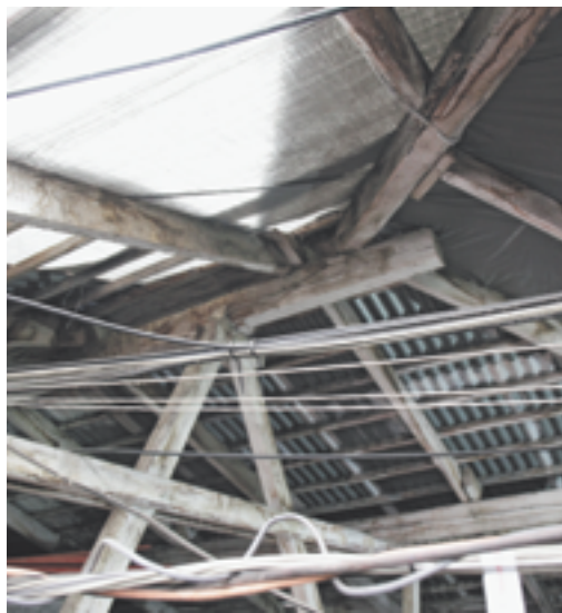
Железная крыша на Горького, 24 частично снята, ремонт завершат к осени
