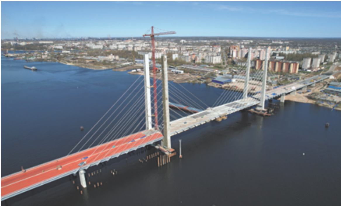
По гидроизоляции через мост уже удалось проехать. Скоро уложат асфальт и в августе откроют переправу
