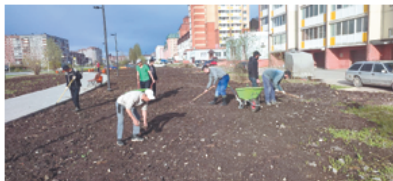
На Городецкой подрядчик убирает строительный мусор с газонов и готовит их к озеленению
