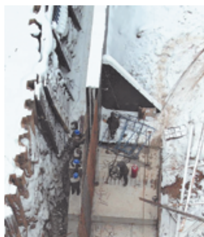
На Соборной горке возводят подпорную стенку
