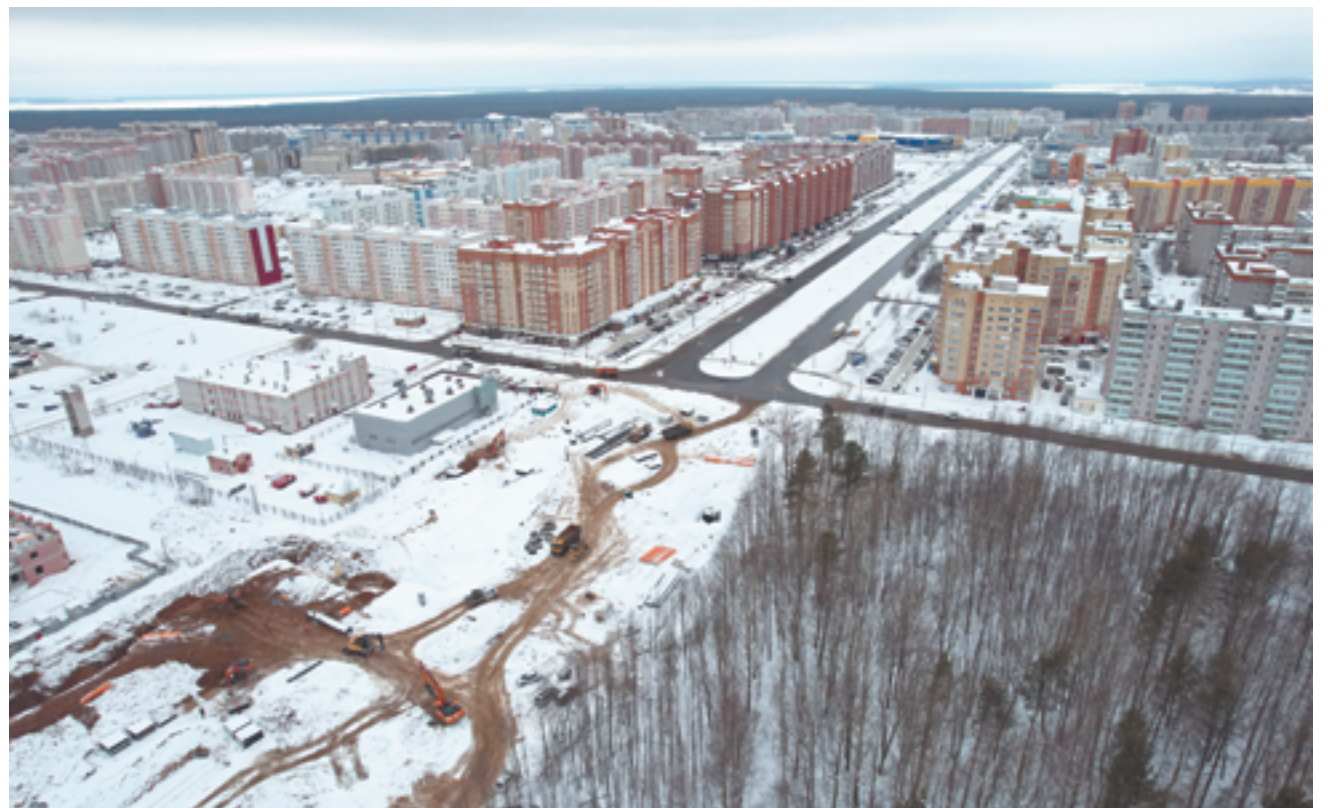
На Шекснинском проспекте строители прокладывают сети и делают основание для будущей дороги
