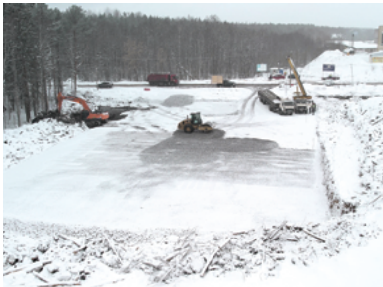
Строители вывезли с будущей парковки тысячи кубометров заболоченного грунта, отсыпали твердое основание, в котором не вязнет техника
