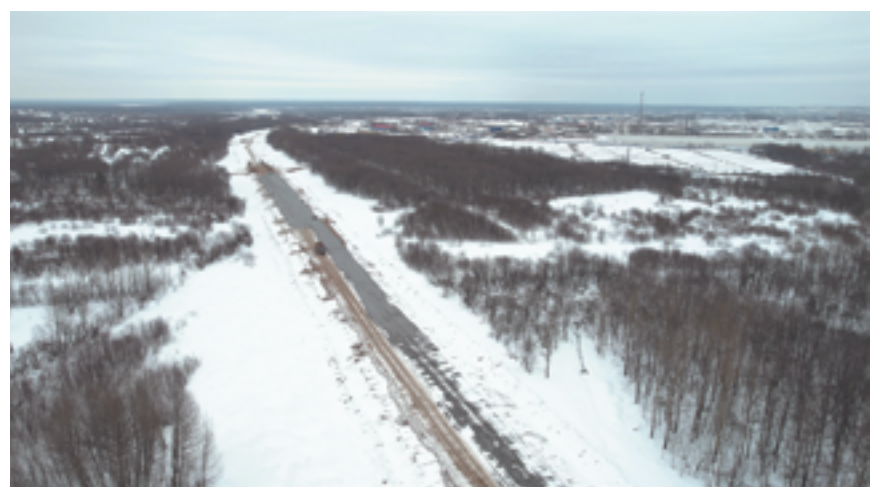
Уже видны очертания Северной объездной дороги, ее начали отсыпать шлаком
