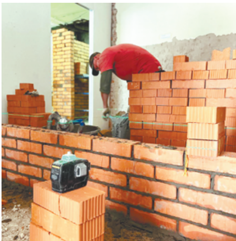
Подана заявка в Москву на капитальный ремонт нескольких школ Череповца
