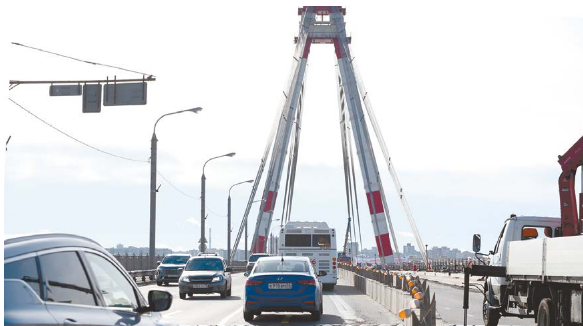
Ремонт Октябрьского моста идет круглосуточно и без выходных, поэтому капремонт проезжей части займет только один год, а не два
