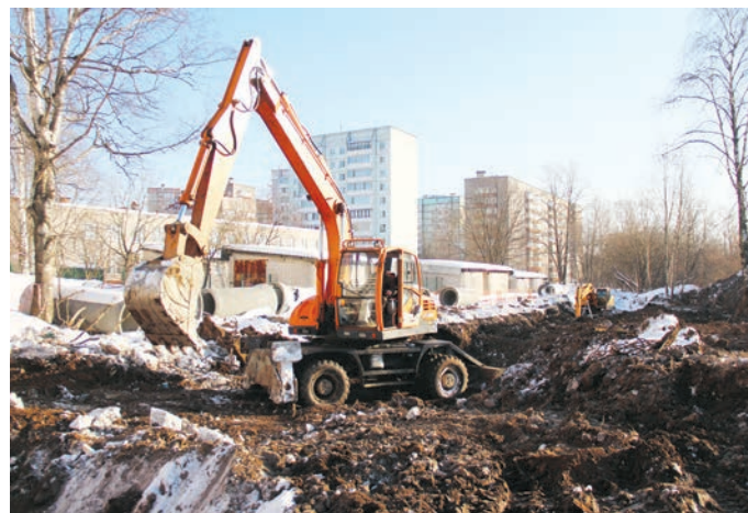
На улице Белинского идет ремонт коллектора 1977 года
