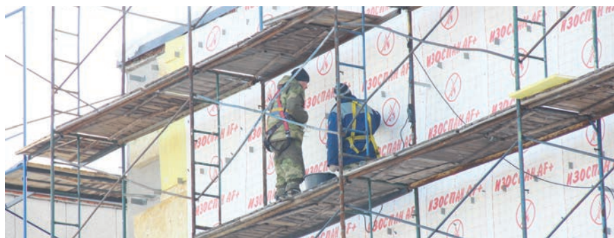
Навесной фасад крепят в основном на старую штукатурку. И этому есть причины
