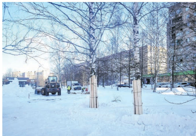
Стволы деревьев на Архангельской закрывают деревянными щитами, чтобы не повредить техникой
