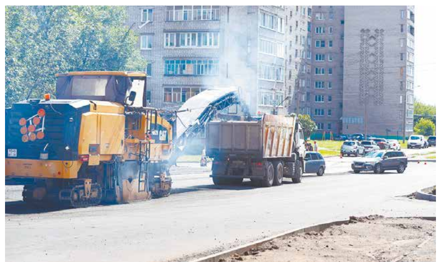
Улицу Моченкова ремонтируют целиком. Подрядчик снял старый асфальт и готовится укладывать новый
