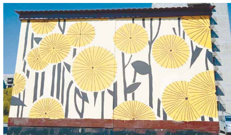
Предприятие «Электросеть» привлекло молодежь, чтобы расписать красивыми рисунками трансформаторные будки
