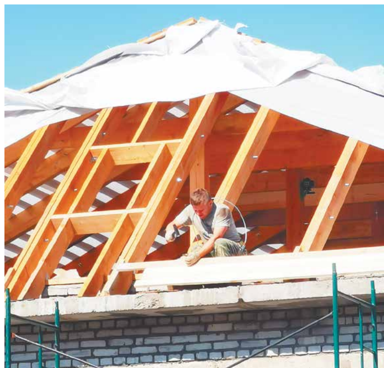
В детском саду № 126 чинят крышу, благоустраивают территорию, заменили окна
