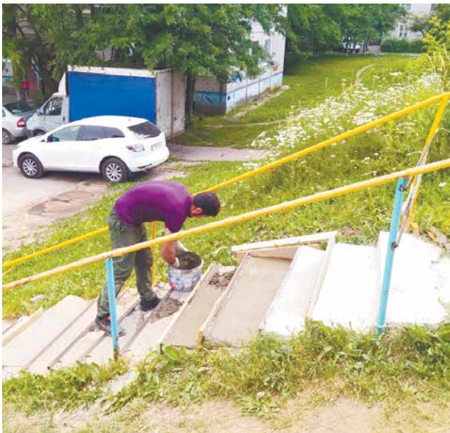
При содействии управы началось восстановление аварийной лестницы на Беляева, 40
