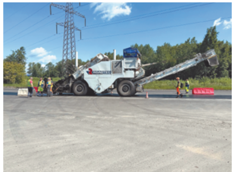
Ремонт почти 13 километров Северного шоссе — самый масштабный в этом году
