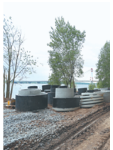
На набережной появится и ливневая канализация, которой не было
