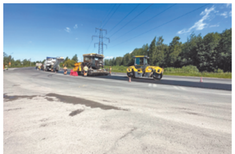
На дороге уложено два слоя асфальта, площадь каждого — 180 тысяч квадратных метров
