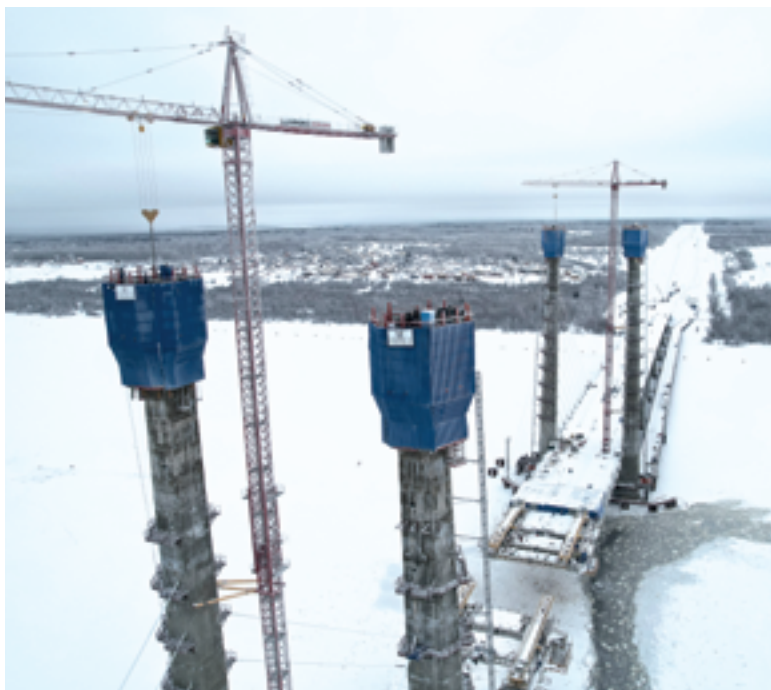
Бетонирование пилонов практически завершено. Строители заканчивают работу с вантами
