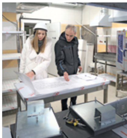
На Батюшкова, 10А идет сборка пищеблока, установка мебели и оборудования в группах
