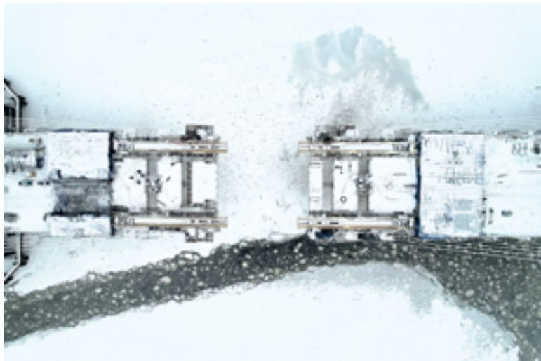
До конца февраля смонтируют последние три блока пролетного строения
