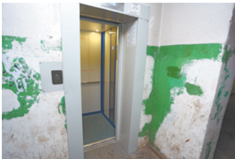
После установки домофона и видеокамер можно будет заняться косметическим ремонтом
