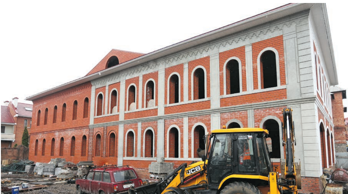
Административное здание на Дзержинского тоже строят в традициях прошлого
