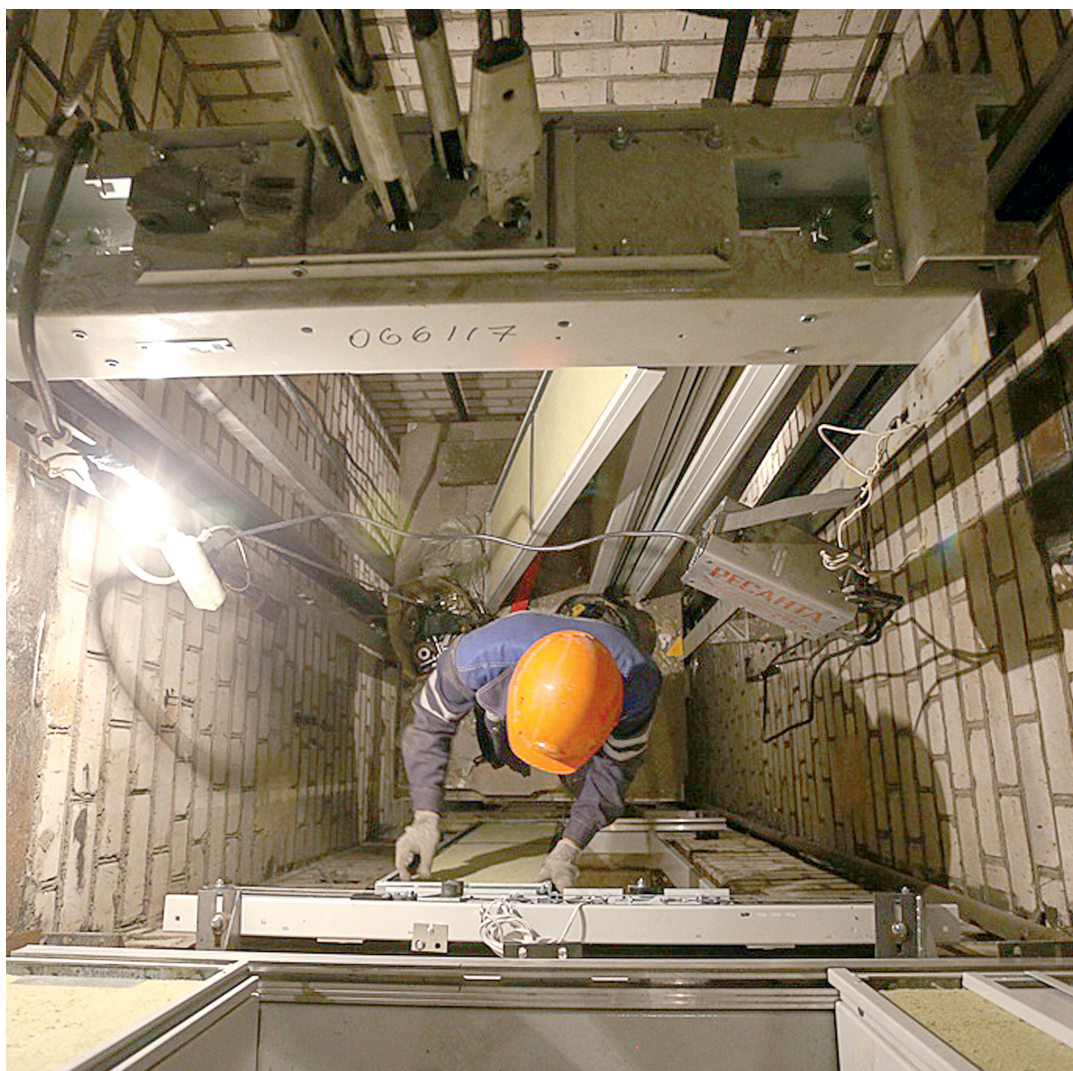
Монтажники начинают ремонт с шахты. Передвигаясь на старом лифте, меняют двери, наличники, крепления
