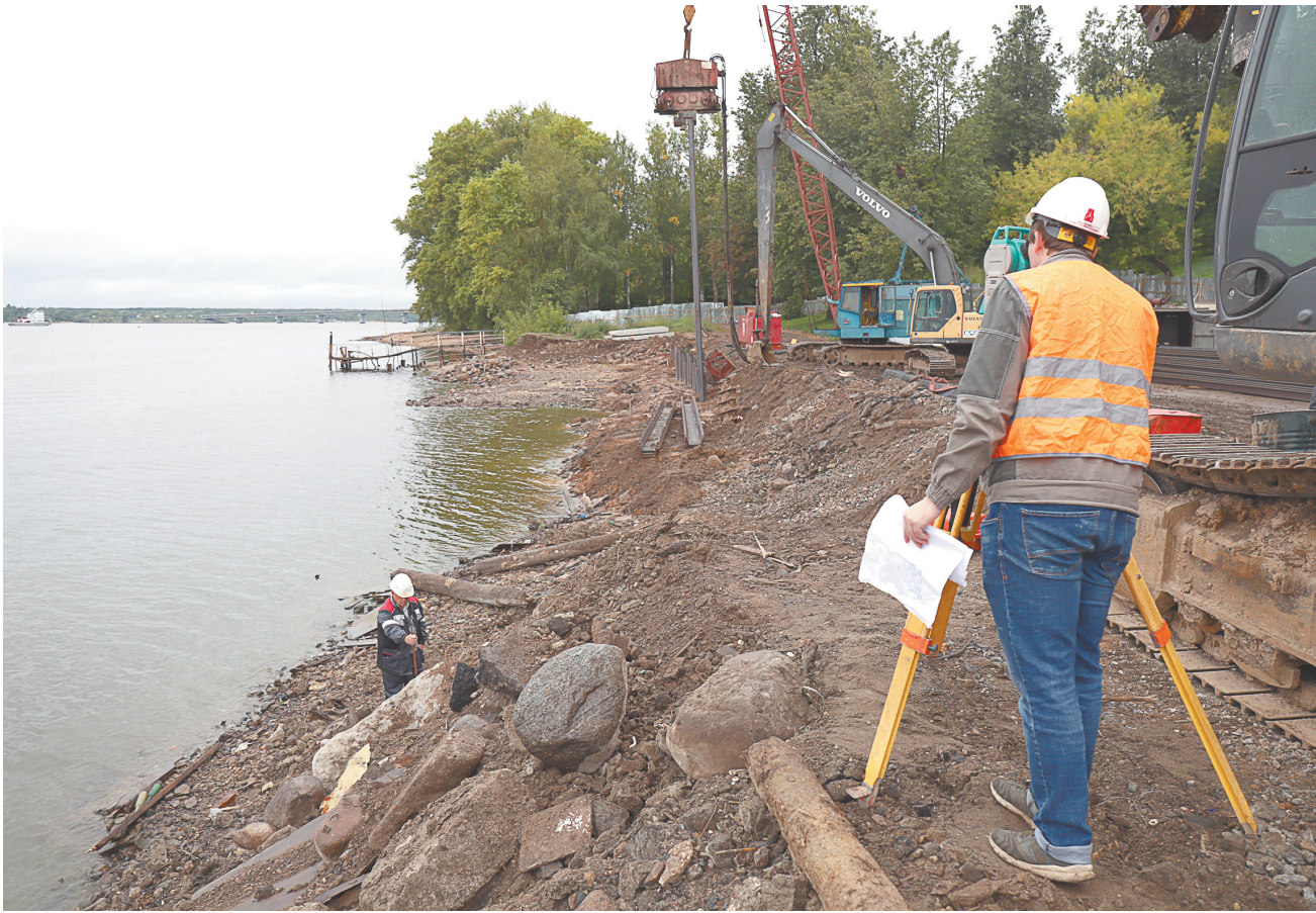
В берег набережной забивают сначала металлопрофиль, затем — сваи, а затем будут заливать новую бетонную стену. Старая была из дерева и сгнила
