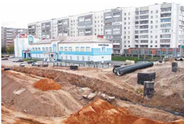
2010 г. Строительство набережной у Ягорбского моста. Фото: В.В. Дворянов
