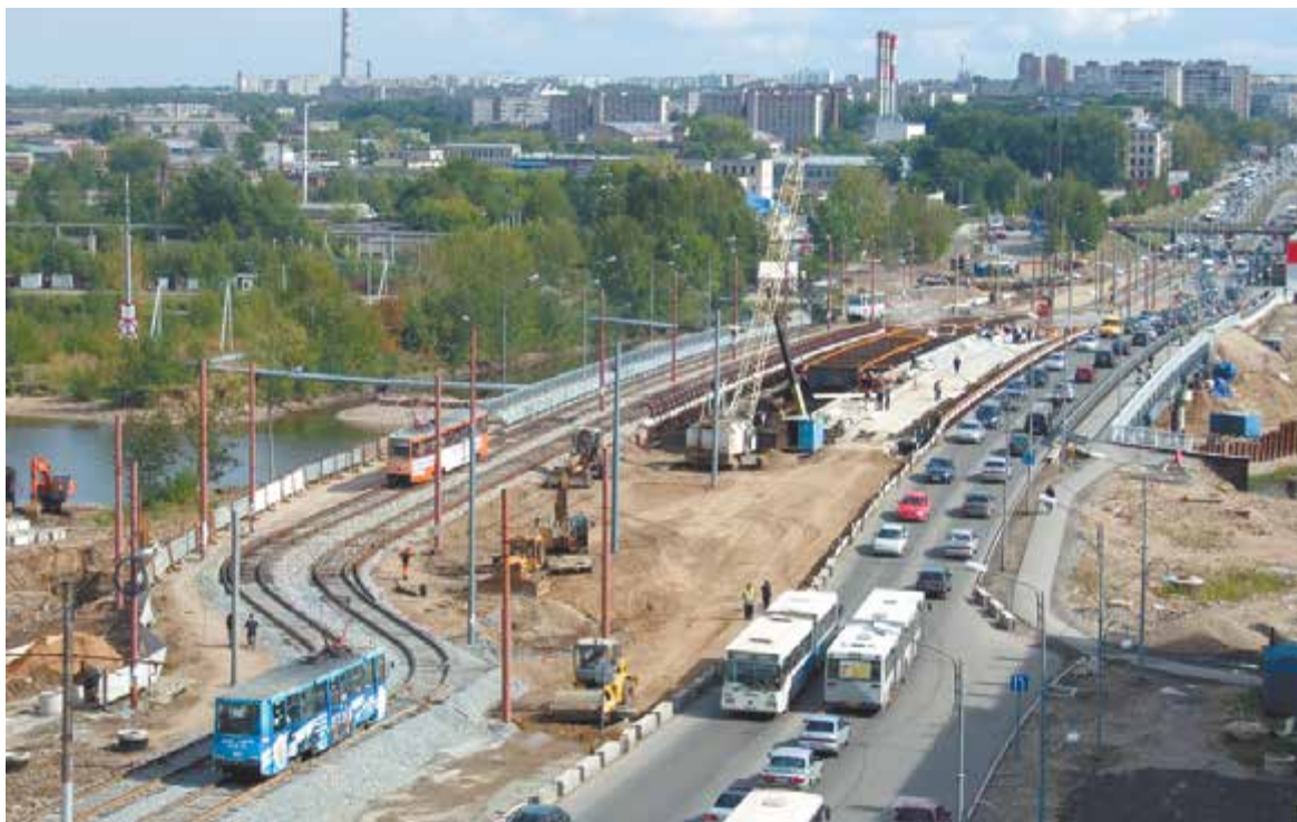
Реконструкция Ягорбского моста. 25 августа 2010 года. Трамвайные пути временно перенесены. Фото: Илья Брезгунов
