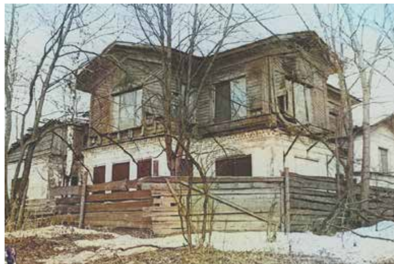
Бывший дачный дом Милютиных до реконструкции
