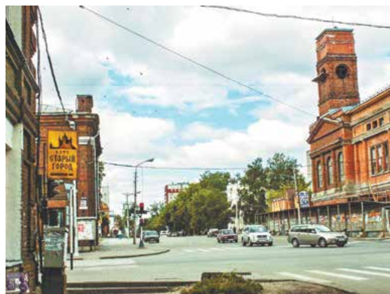
24 июня 2005 года. Вид от Советского проспекта на улицу Ленина. Идет капитальный ремонт здания Камерного театра. Фото: Вадим Савин
