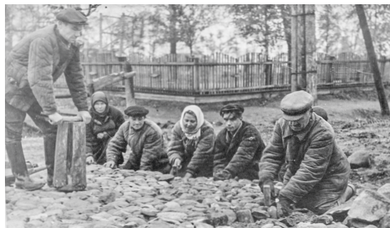
Укладка каменухи на Привокзальной площади. На заднем плане — Железнодорожный сад, 1930-е гг.
