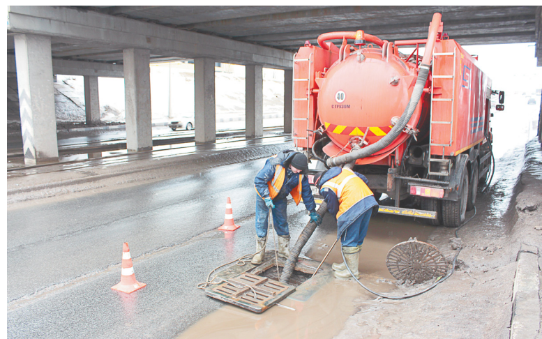
▲ Грязь убирают не только снаружи. Колодцы промывают под давлением 100-150 атмосфер.
