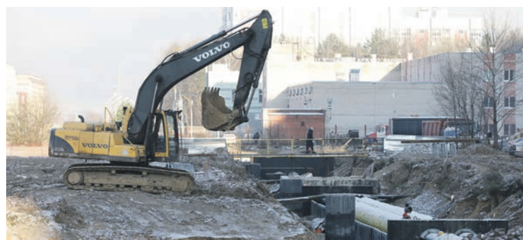
Магистраль вдоль Рыбинской будет обеспечивать теплом новые микрорайоны
