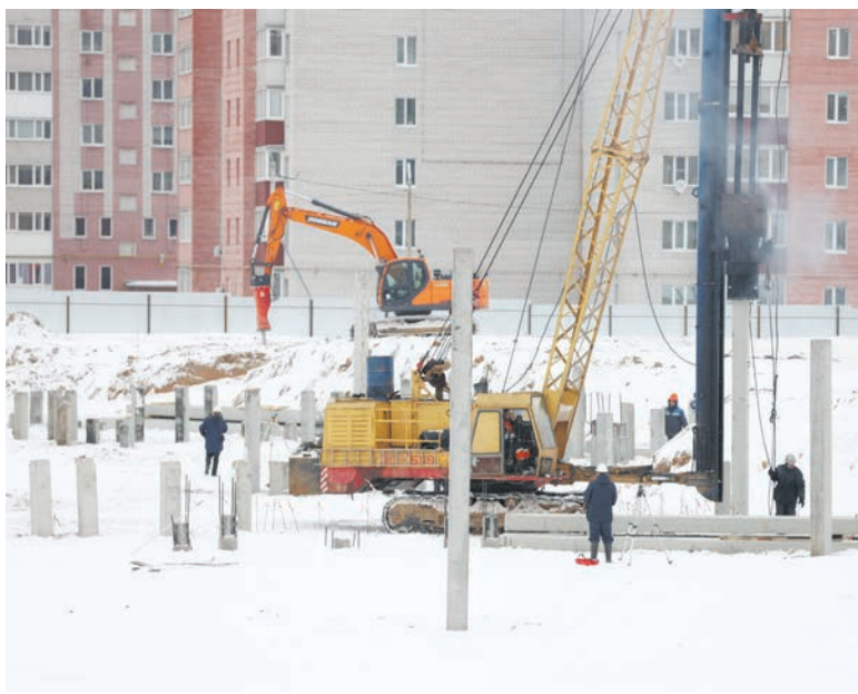
Забивают сваи под школу на улице Ленинградской. В конце года планируют приступить к отделке здания
