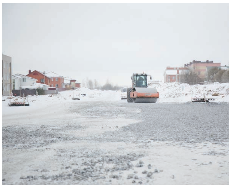
До прихода теплой и сухой погоды строители подготовят основание для асфальтовой дороги за военкоматом
