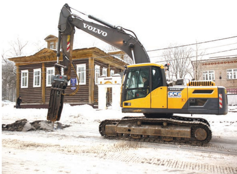
Реконструкцию Советского проспекта начали со снятия старого асфальта
