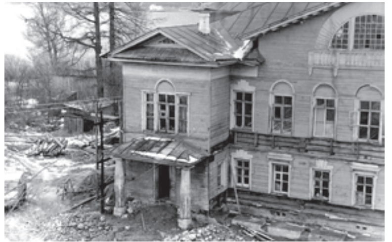
В 1992 году начался второй этап восстановительных работ в барском доме Усадьбы Гальских. В советские годы деревянное здание использовалось для нужд совхоза и под коммунальное жилье. Снимок из фотоархива газеты «Коммунист»
