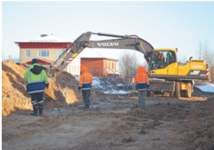
В этом году под будущей асфальтированной дорогой прокладывают сети
