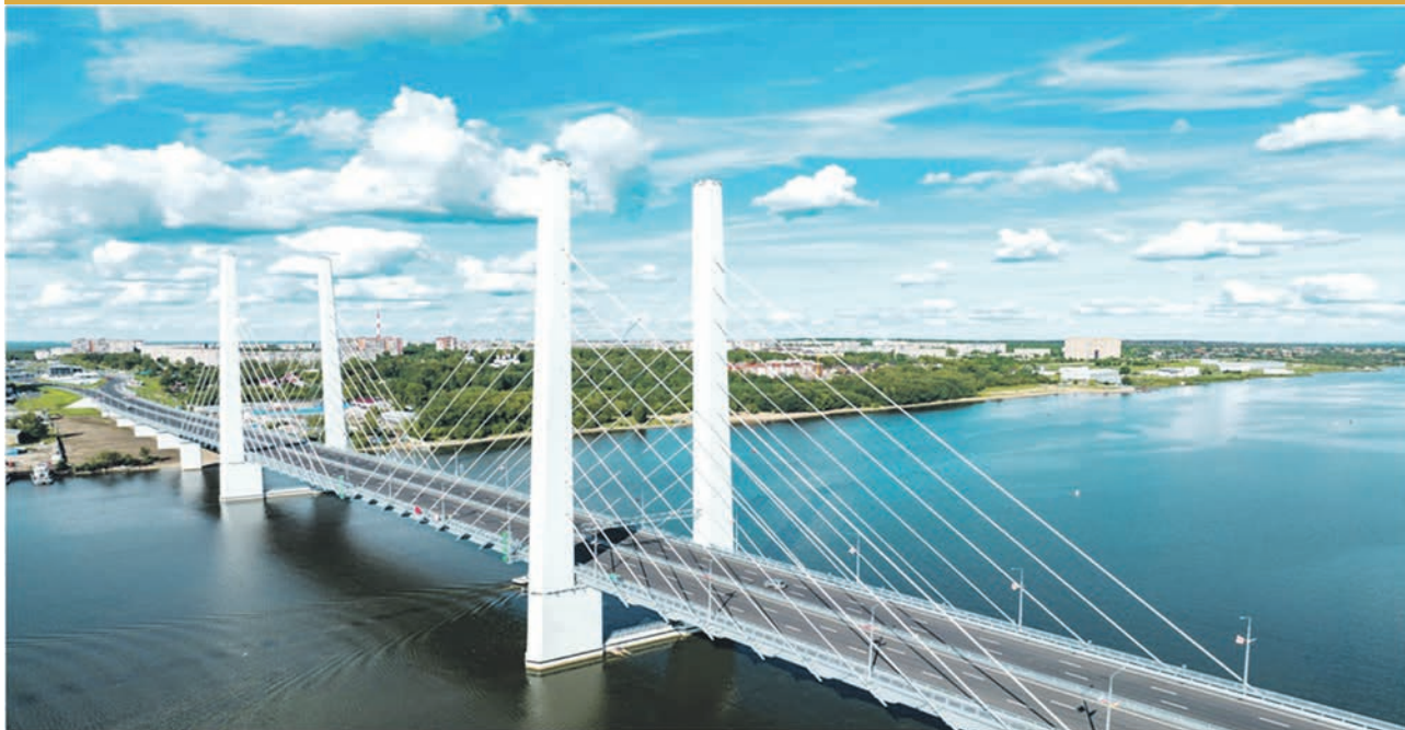
Строительство и расширение Шекснинского проспекта
