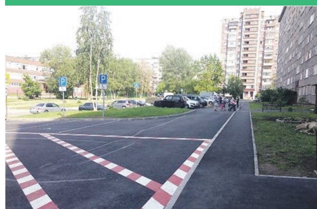
Строительство Александровской и Октябрьской набережных
