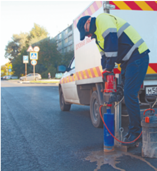
После ремонта на каждой улице в нескольких местах берут пробы асфальта
