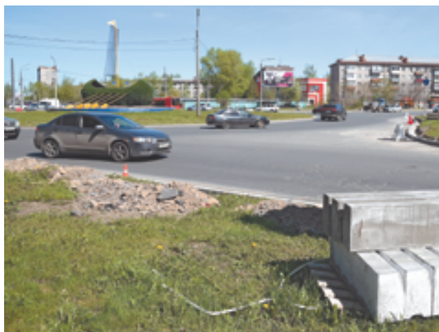
На перекрестке Архангельской и Краснодонцев меняют бордюры и прокладывают новые пешеходные дорожки
