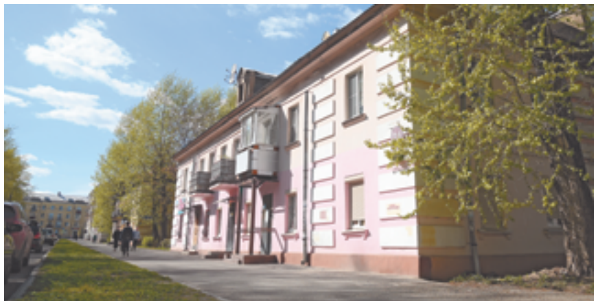
Впервые в программе ремонта фасадов — двухэтажные здания на улицах Максима Горького и Карла Маркса
