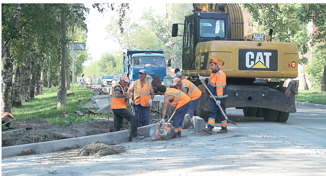
По проекту «Безопасные качественные дороги» на улицах меняют бордюры, укладывают два слоя нового асфальта, приводят в порядок тротуары
