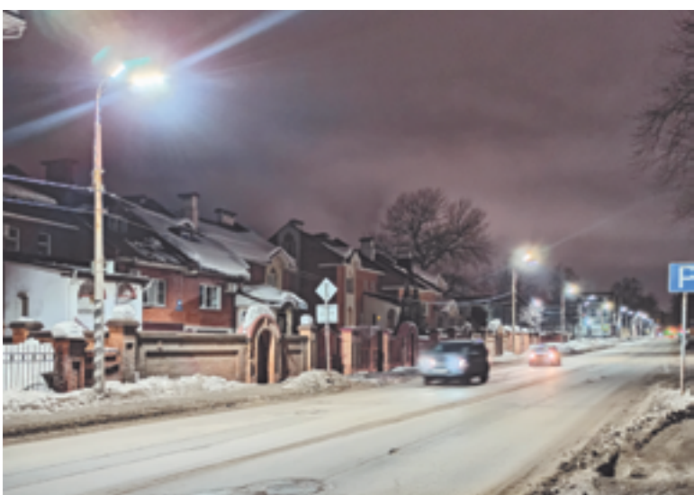
На Карла Либкнехта после замены освещения стало светлее
