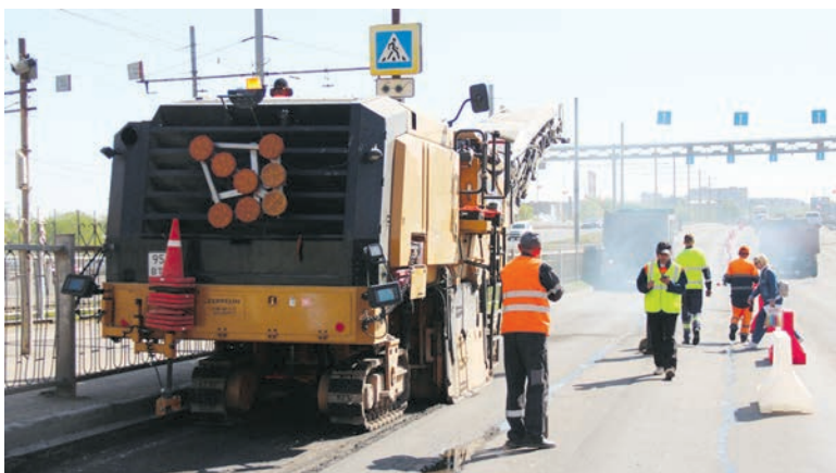
На Ягорбском мосту уберут колеи и сделают ремонт деформационных швов
