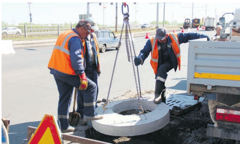
Перед ремонтом дорог выравнивают колодцы, совершенствуют ливневку
