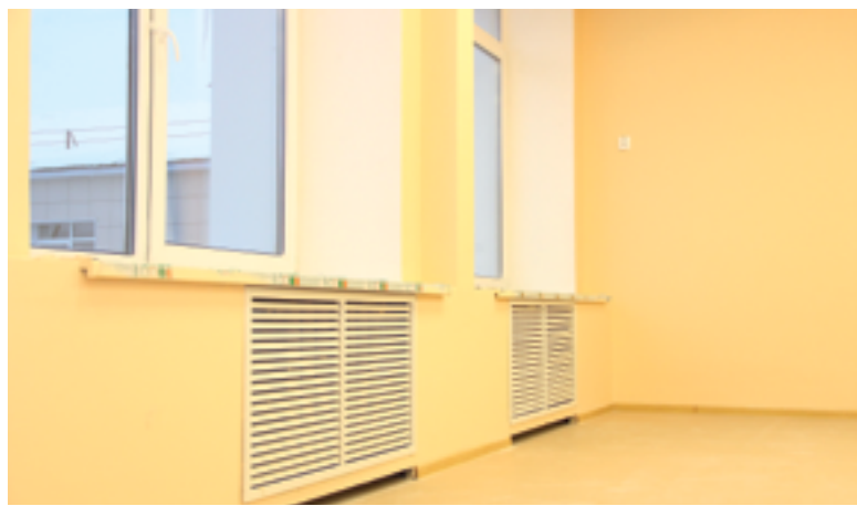
❹ Внутри тоже все новое. Заменены полы, перегородки, заштукатурены и выкрашены стены
