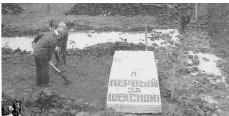
24 июня 1986 года заложен фундамент первого жилого дома за Шексной
