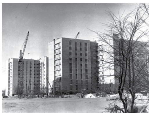
Строительство общежитий химзавода в районе ФМК
