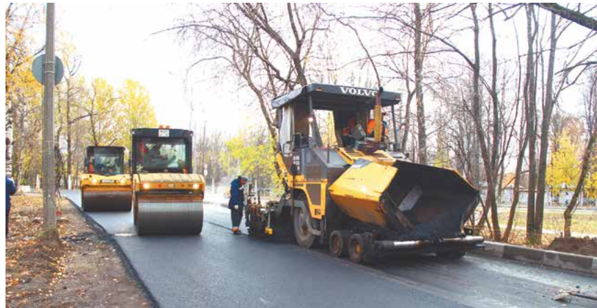
Улицу Данилова и переулок Ухтомского ремонтируют за счет дополнительных средств, выделенных регионом
