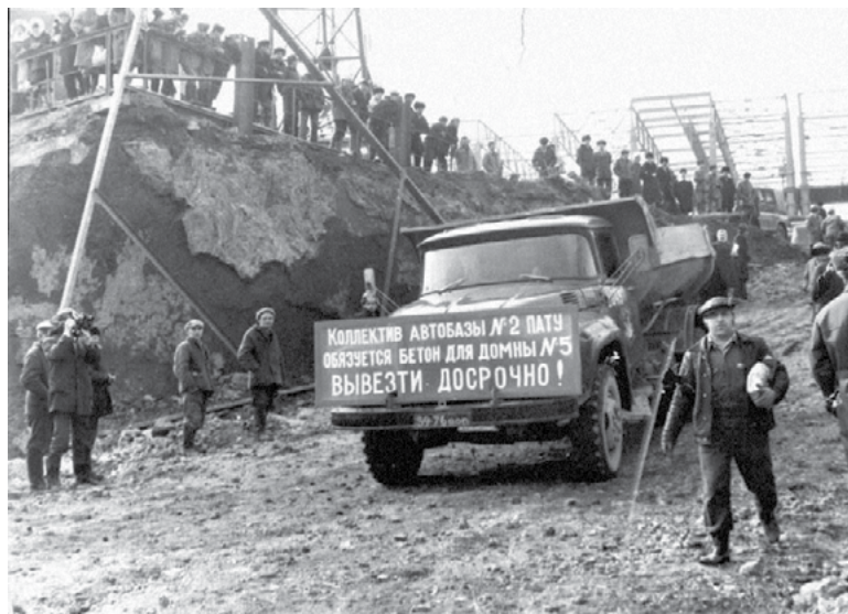
Начало бетонирования основания (пня) домны № 5
