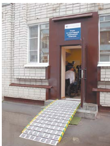
Перед открытием в зале провели комплексный ремонт
