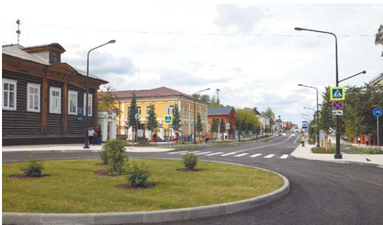
После реконструкции на Советском сохранится движение автомобильного и общественного транспорта
