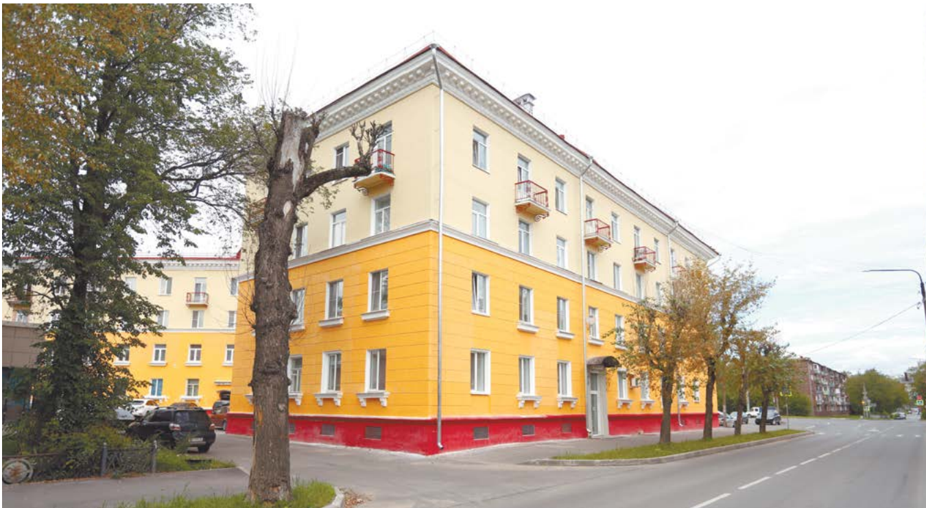
Два нижних и два верхних этажа здания на проспекте Победы, 30 будут отличаться по цвету. Свой цвет (томатно-красный) будет и у цоколя. Оттенки утверждены в управлении архитектуры города.
