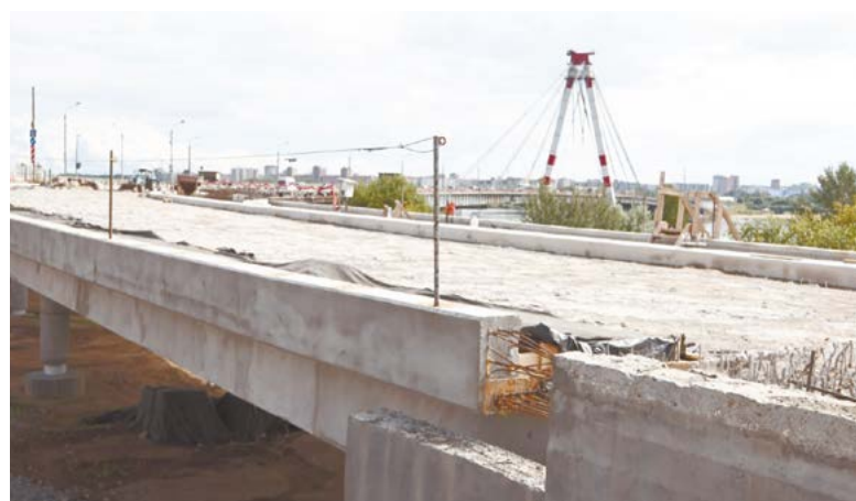
Работы на Октябрьском мосту начались 1 мая этого года и идут по графику
