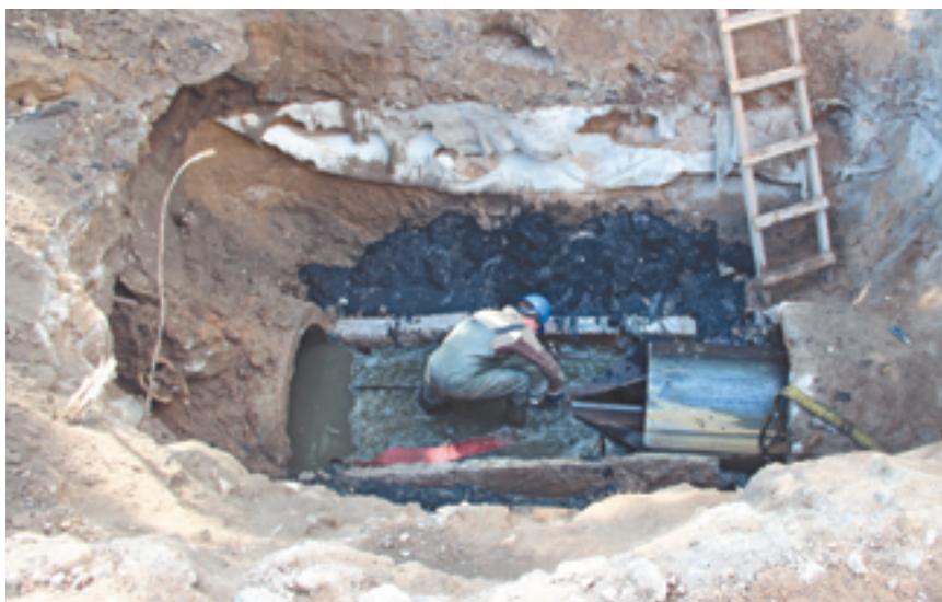
«Водоканал» сейчас ремонтирует центральные городские коллекторы
