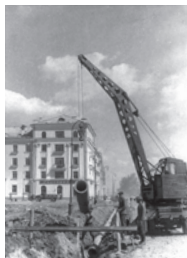
Прокладка дренажных труб на площади Metallургов. 1953 год
