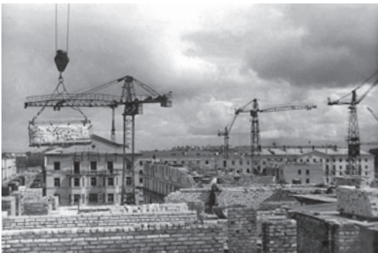
Строительство домов на улицах Metallurgov и Stal'evarov. Июль 1956 года
