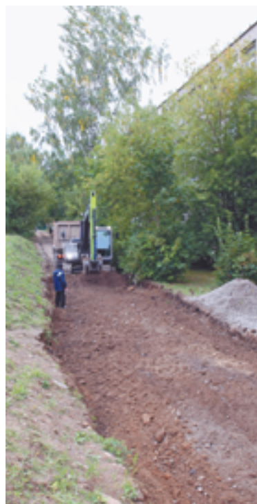
Идет реконструкция проезда между 5-й и 9-й школами
