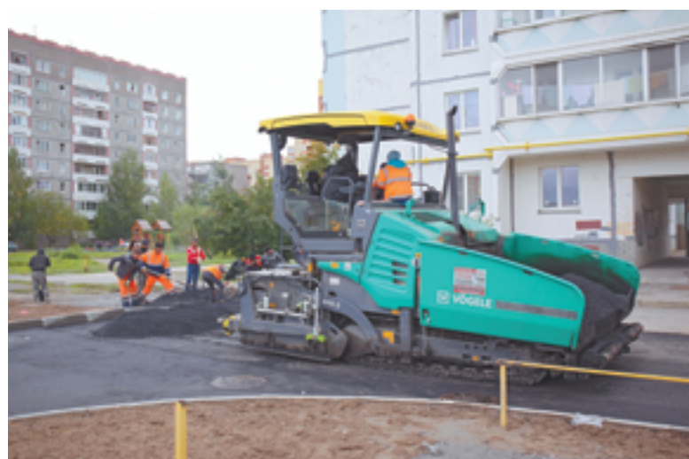
От улицы Годовикова в сторону нового детского сада заасфальтировали проезд
