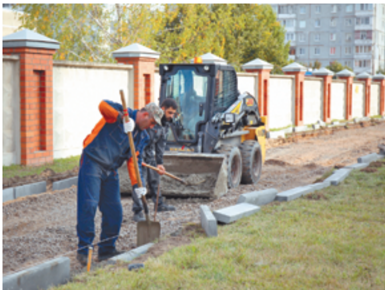
У котельной на Краснодонцев приводят в порядок тротуары. Параллельно от Гоголя до Архангельской идет ремонт дороги
