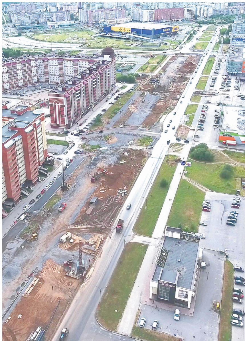
Уже сейчас видны очертания второй половины Шекснинского проспекта, делают широкий тротуар вдоль домов
