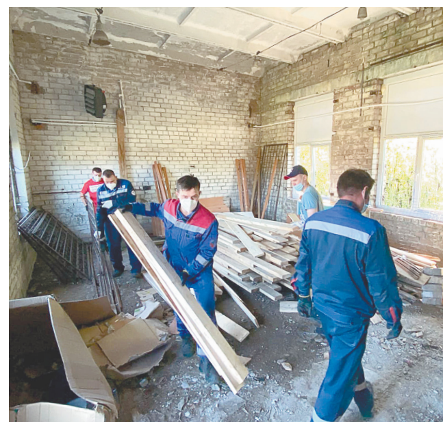
Сотрудники «Северстали» ремонтируют пол и стены в здании, чтобы здесь могли разместиться собаки
