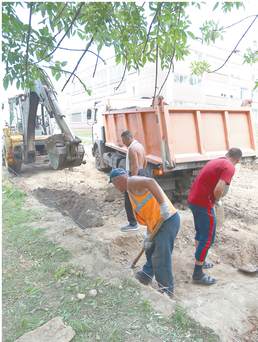
Рядом с будущим сквером, у школы № 31, готовят место под спортплощадку
